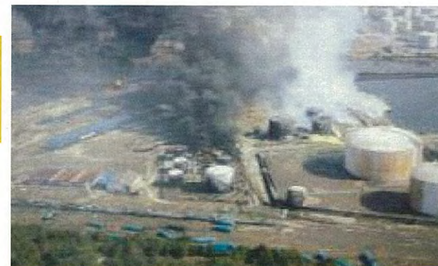
仙台塩釜港: 仙台製油所で発生した火災
