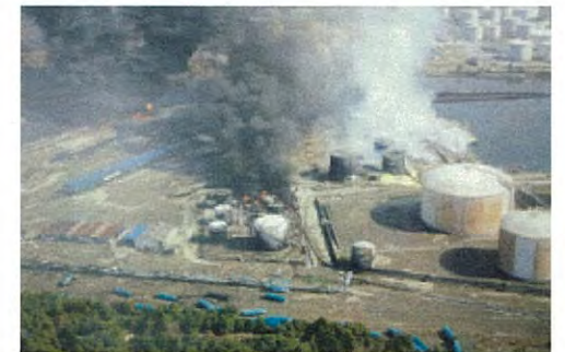
仙台製油所における火災発生状況
