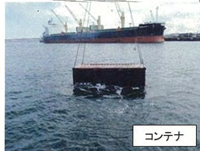
■ 障害物の引き揚げ作業
