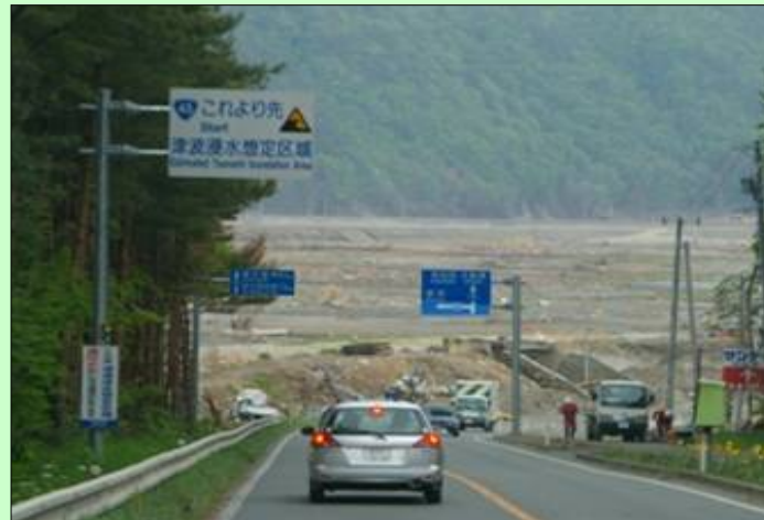
津波浸水想定区域の表示(岩手県釜石市)
