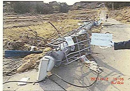
▲CCTV破損 宮城県気仙沼市
