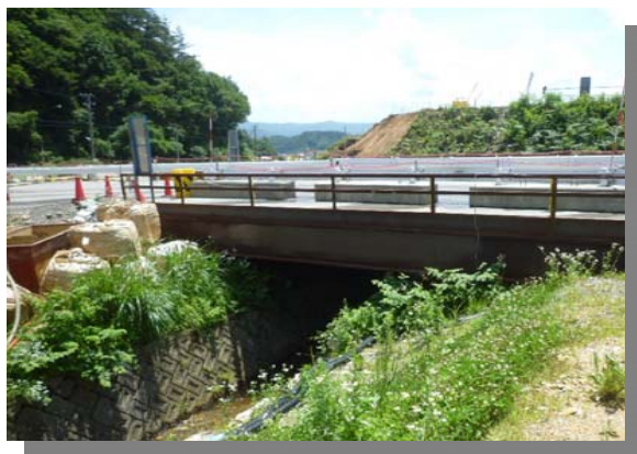
仮橋設置の例
