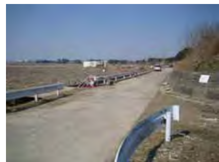
仙台東部道路より陸側(西側)
