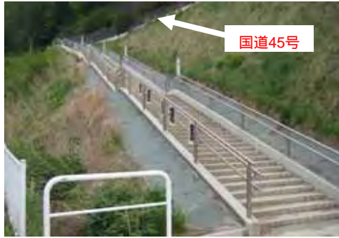
津波避難階段（岩手県岩泉市）
