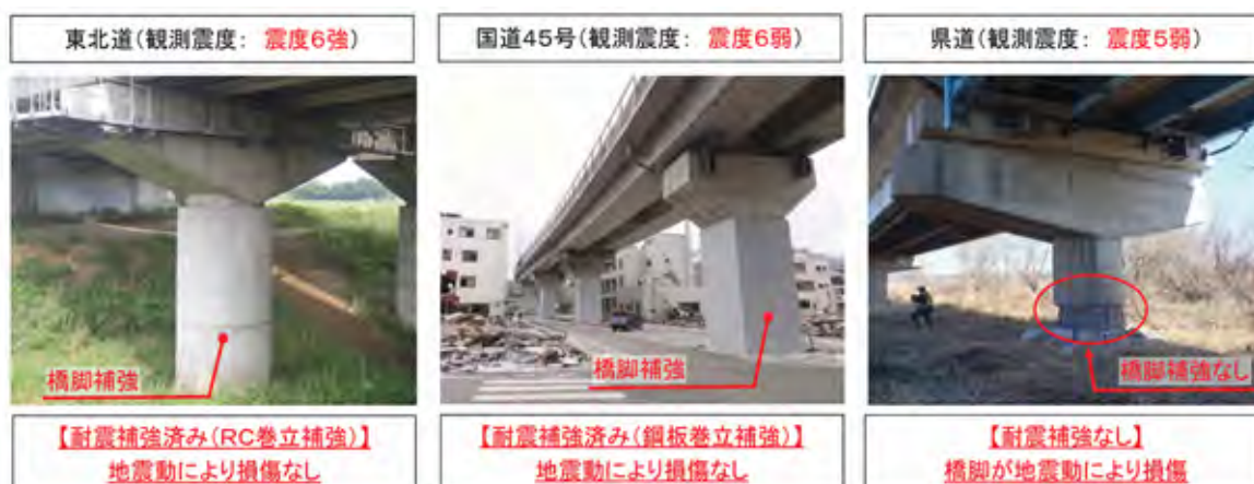
橋脚耐震補強(東北道、国道45号)
