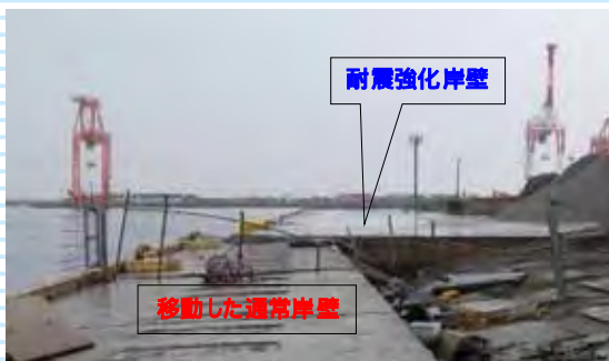
耐震強化岸壁（仙台塩釜港 仙台港区）
