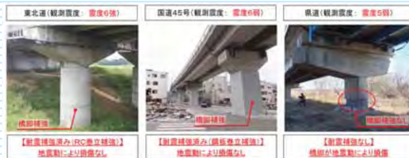
橋脚耐震補強（東北道、国道45号）
