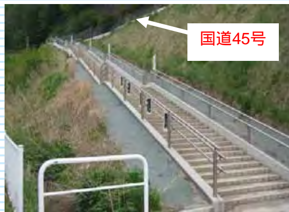
津波避難階段 （岩手県岩泉市）
