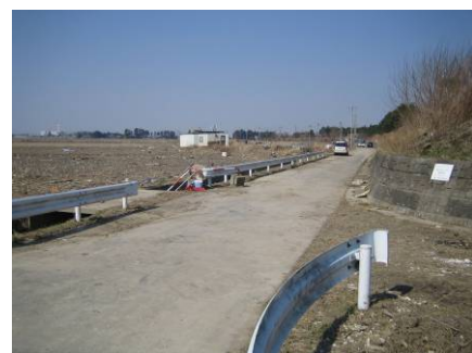
◇仙台東部道路より陸側(西側)
