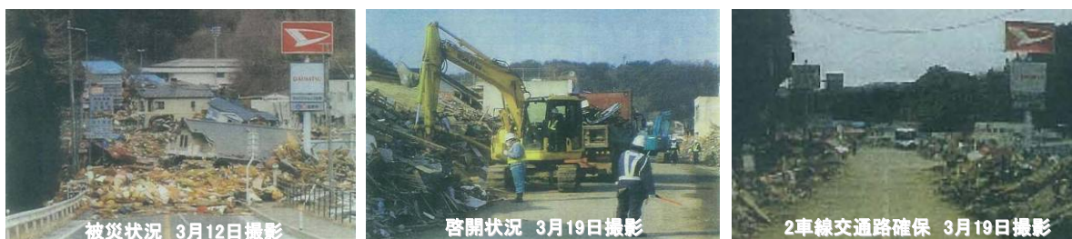
◇道路啓開の事例 国道45号（岩手県宮古市田老地区）
