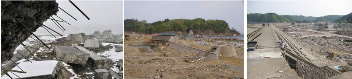
◇津波で損壊、越流した田老防潮堤（岩手県宮古市）
