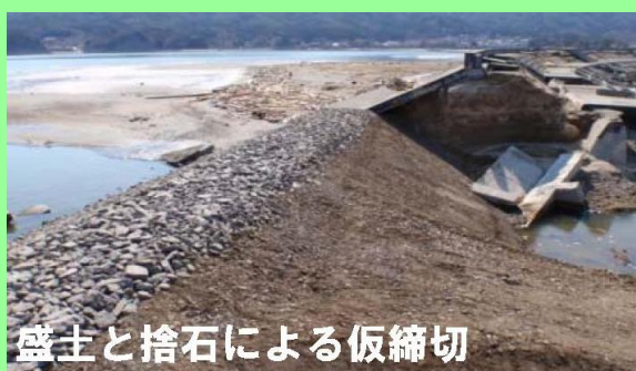
盛土と捨石による堤防仮締切設置状況
