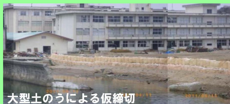
大型土のうによる堤防仮締切設置状況
