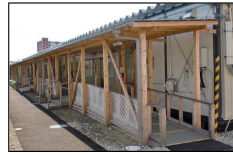
仙台市 仮設住宅のバリアフリー化
