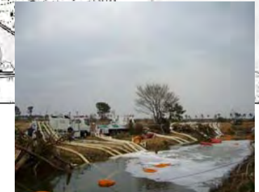
●宮城県東松島市東名地区での排水事例
