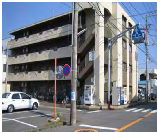
津波緊急避難協力ビル(私有建築物)
