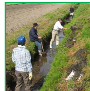
農地・水保全管理支払における水路の泥上げ(三重県伊賀市)
