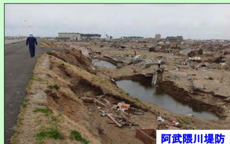
津波が堤防を越流し、堤防裏側を大きく洗掘。
