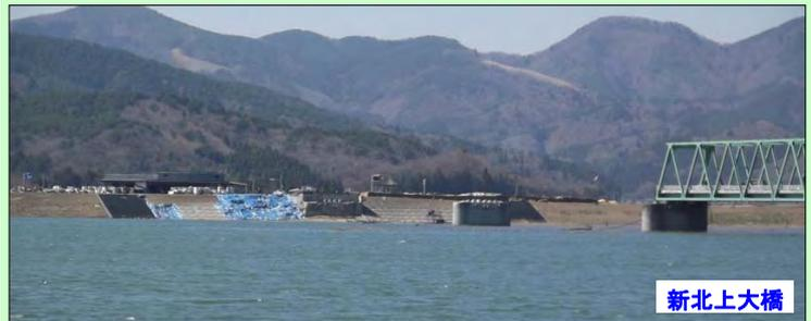
7径間のうち2径間が落橋し上流600mまで移動。津波により橋桁が持ち上げられ、押し流されたと考えられる。
