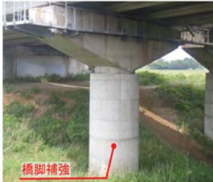
【耐震補強済み(RC巻立補強)】
