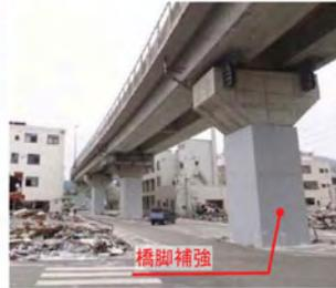
【耐震補強済み(鋼板巻立補強)】
