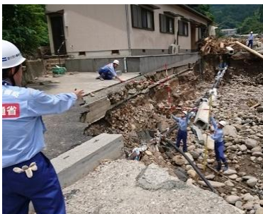
河川被害状況の調査
