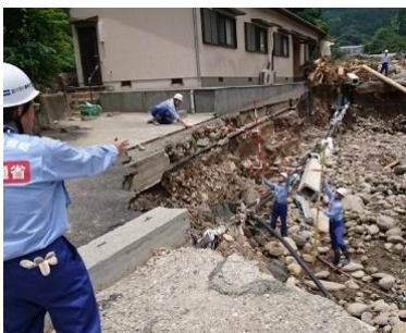
河川被害状況の調査
