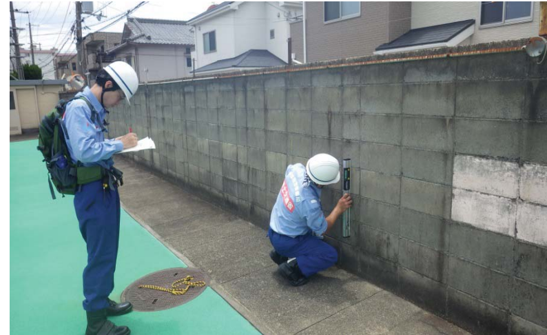
ブロック塀の応急危険度判定調査
