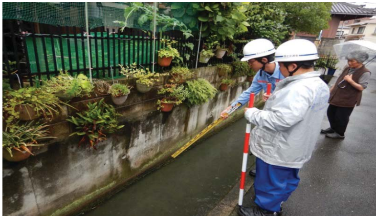
茨木市内における被災状況調査（河川②班）
