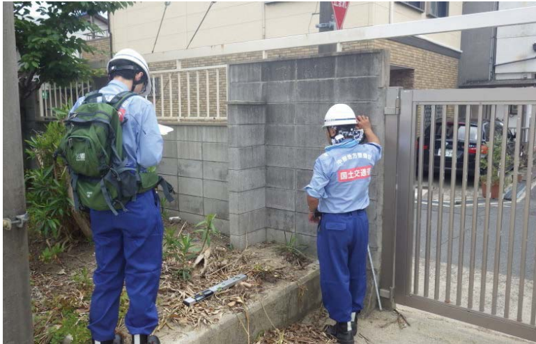
ブロック塀の応急危険度判定調査
