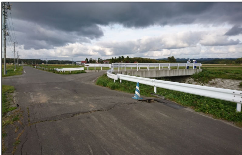
豊沢地区での現地調査（道路）
