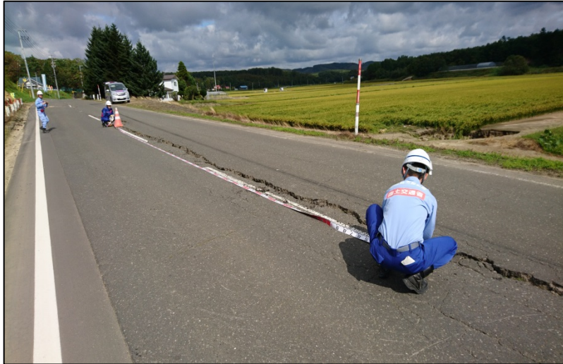
豊沢地区での現地調査（道路）
