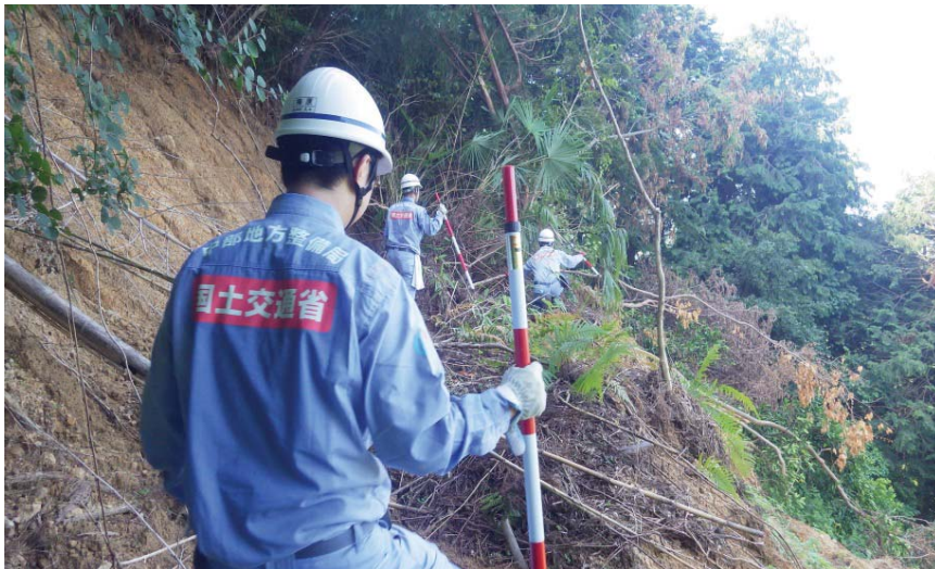
宇和島市内での現地調査（道路）
