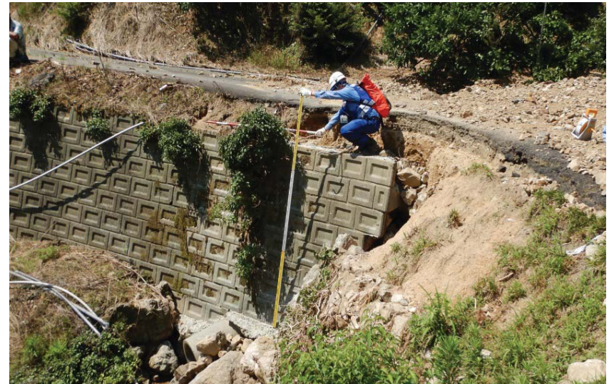
宇和島市内での現地調査
