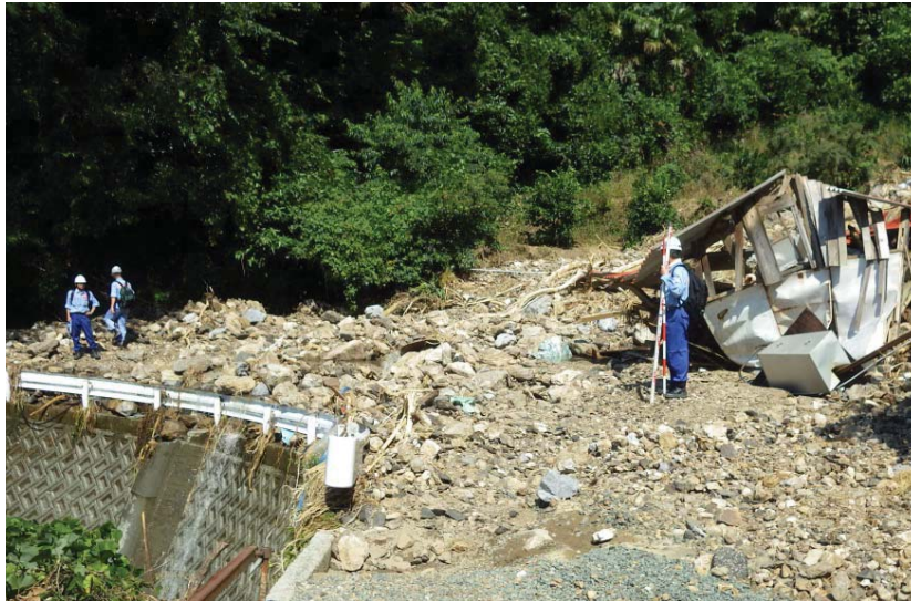
宇和島市内での現地調査
