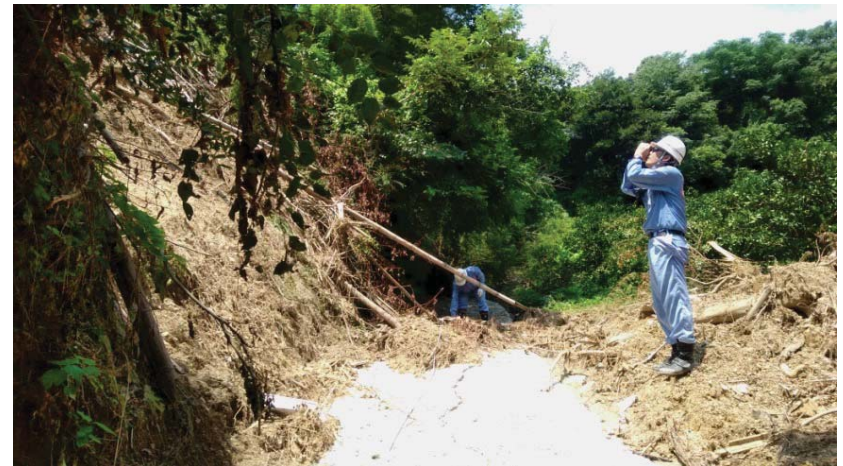
宇和島市内での現地調査（道路）
