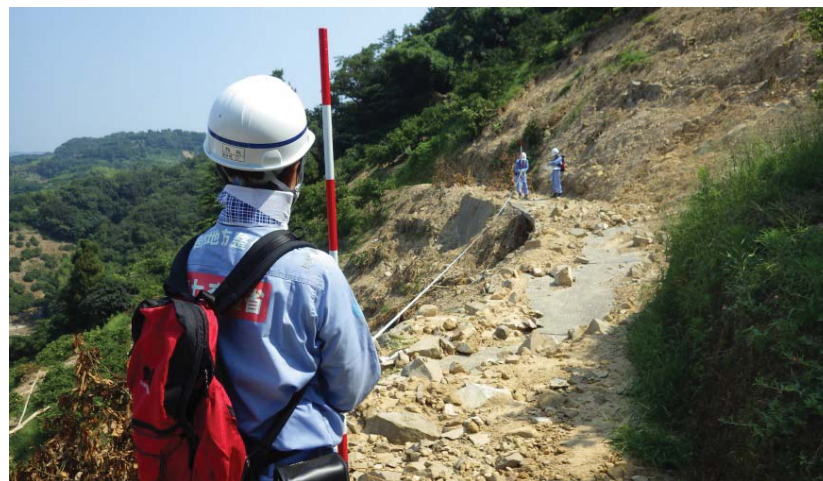
宇和島市内での現地調査（道路）
