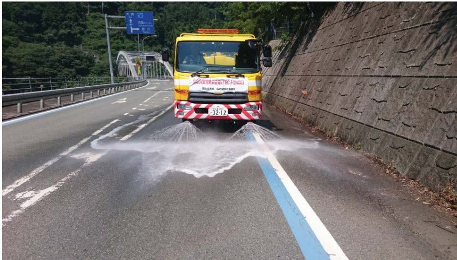
散水車による路面清掃作業 (7/15)
