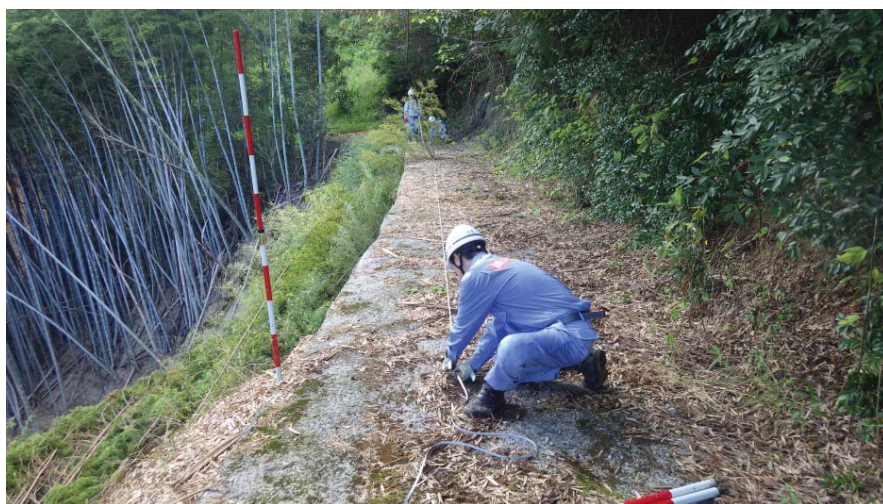
宇和島市内での現地調査（道路）
