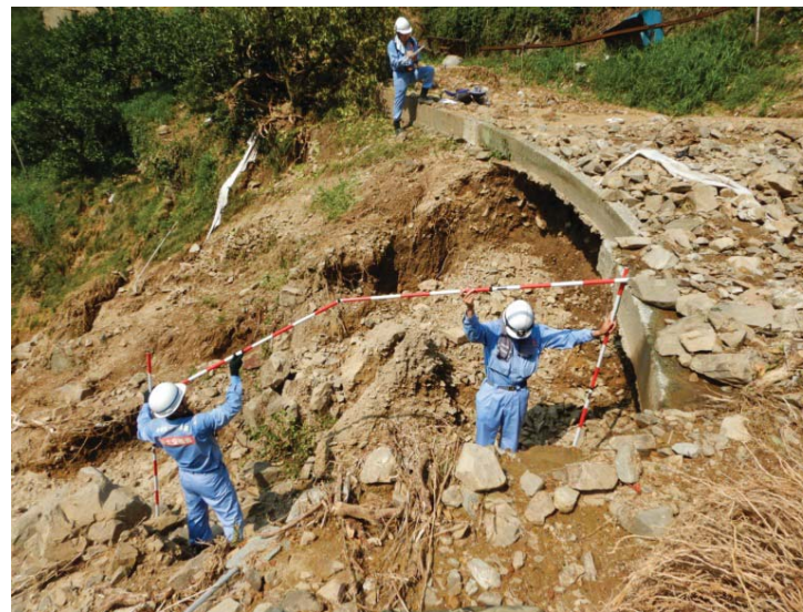
宇和島市内での現地調査（道路）
