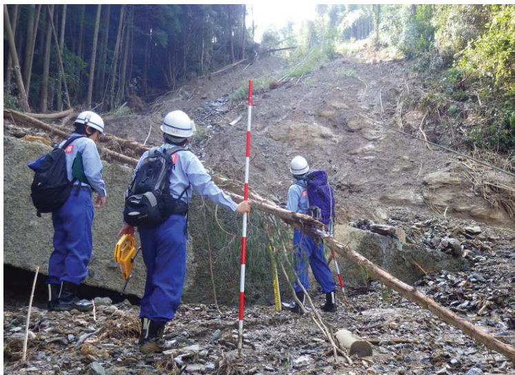
大洲市内での現地調査①（河川）
