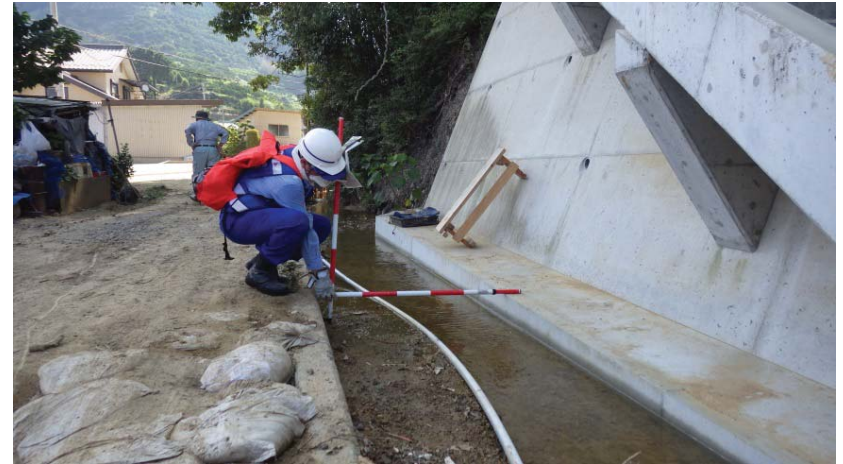
宇和島市内での現地調査（河川）
