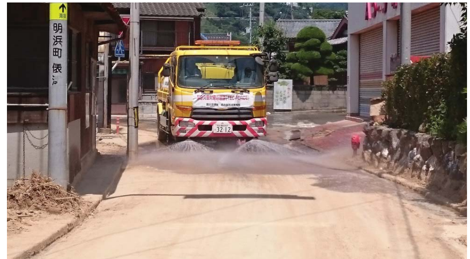
散水車による路面清掃作業
