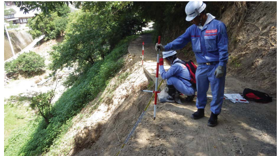
宇和島市内での現地調査（道路）
