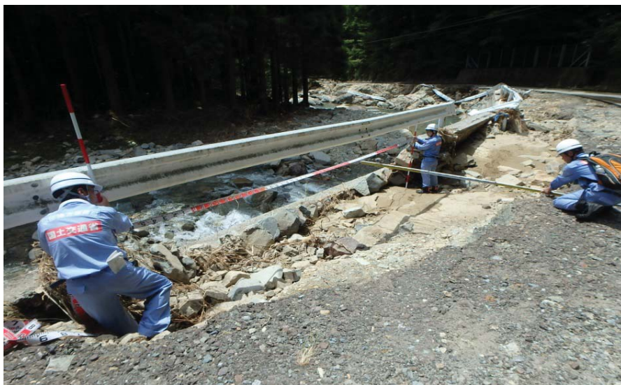
下呂市内での現地調査
