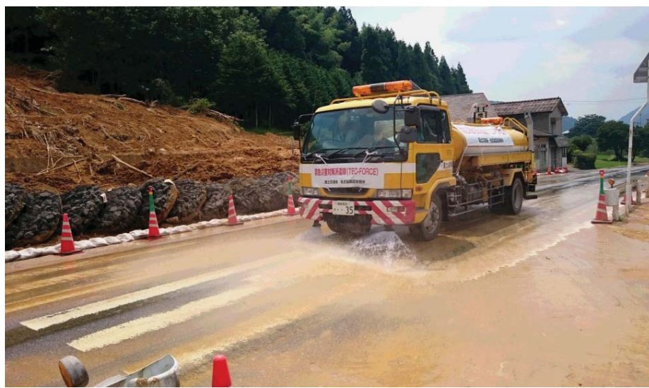
散水車による路面清掃作業（国道197号）
