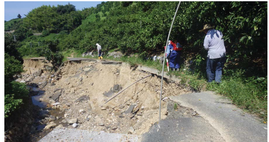
宇和島市内での現地調査
