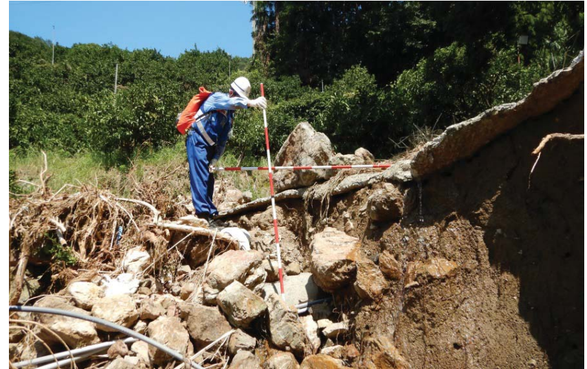
宇和島市内での現地調査
