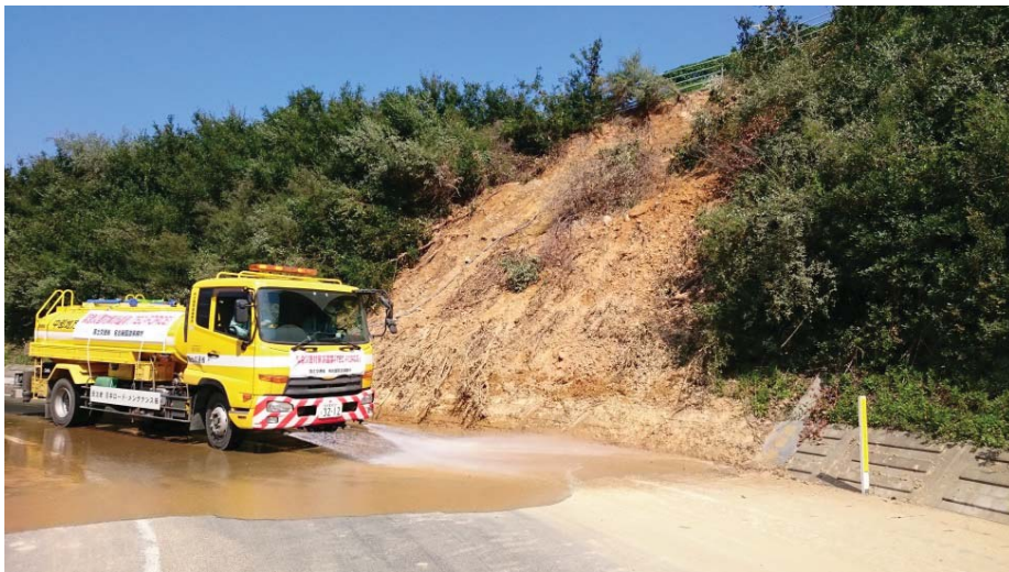
散水車による路面清掃作業
