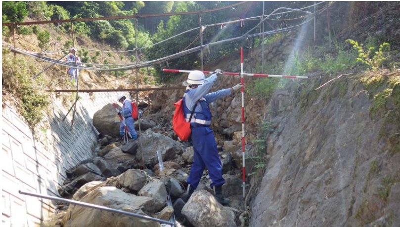
宇和島市内での現地調査
