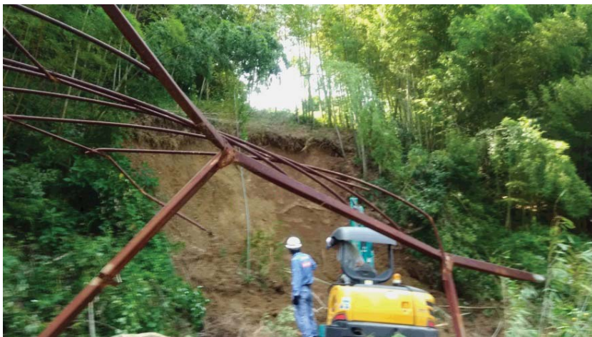
宇和島市内での現地調査（道路）
