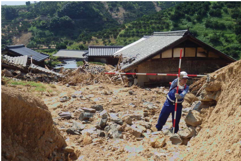
宇和島市内での現地調査
