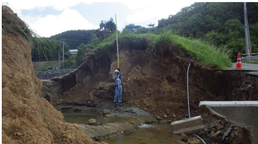
宇和島市内での現地調査（河川）
