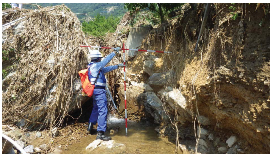
宇和島市内での現地調査
