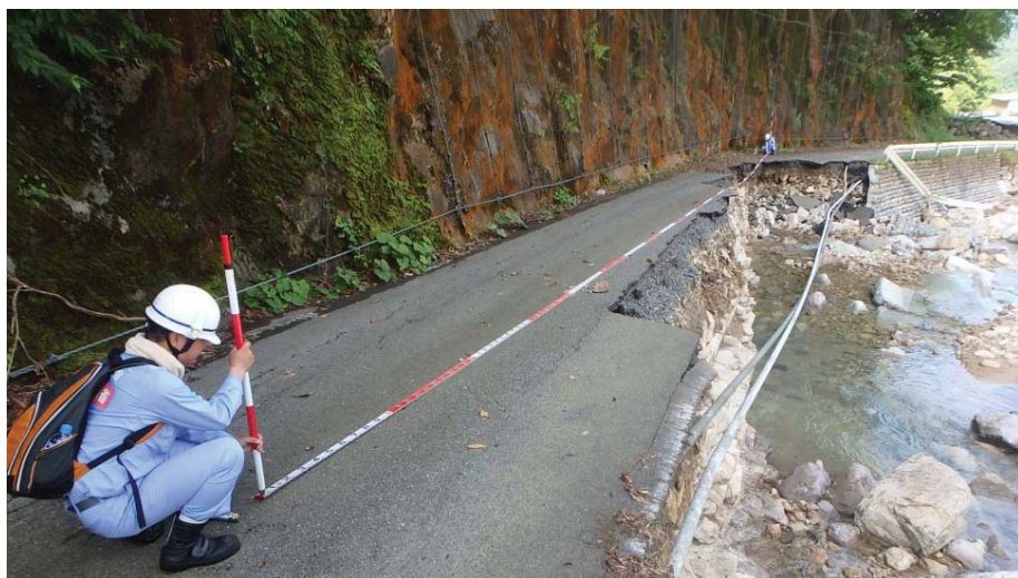
下呂市内での現地調査（道路）
