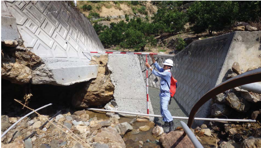
宇和島市内での現地調査
