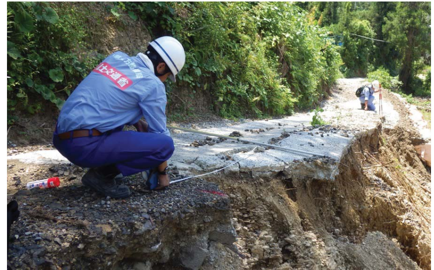
宇和島市内での現地調査
