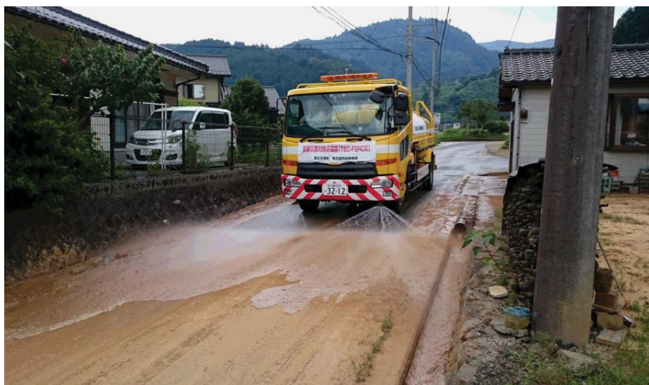
散水車による路面清掃作業（国道197号周辺道路）
