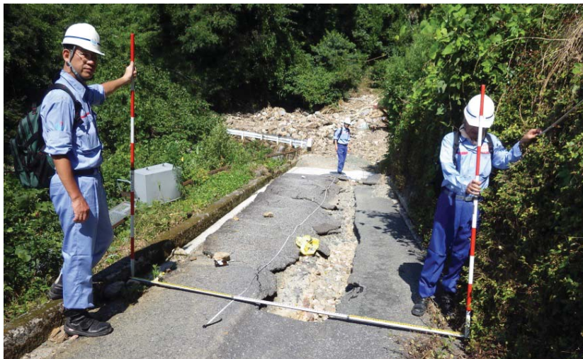
宇和島市内での現地調査
