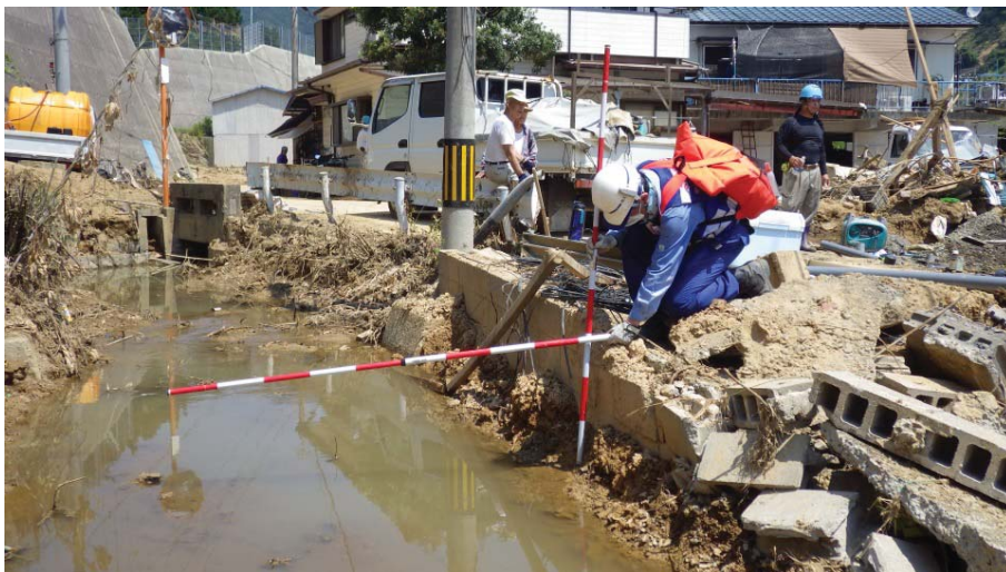
宇和島市内での現地調査
