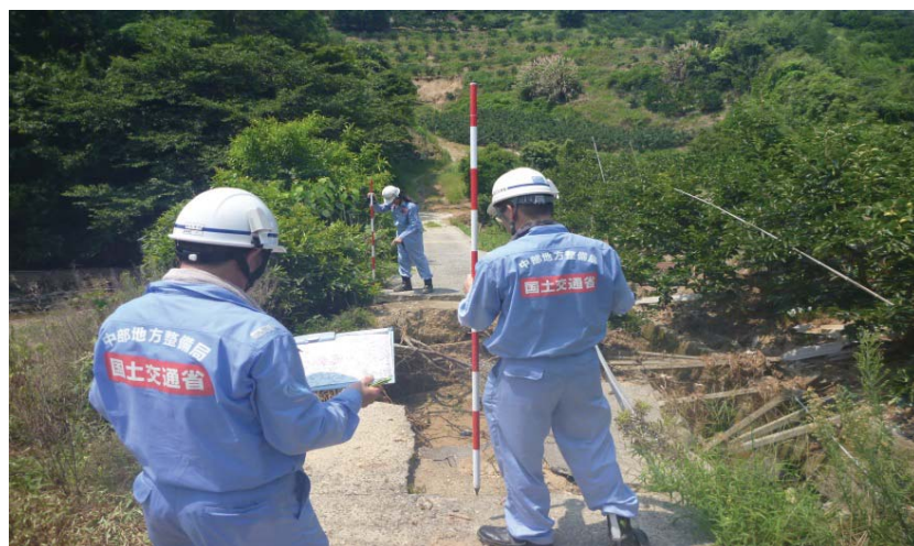
宇和島市内での現地調査（道路）
