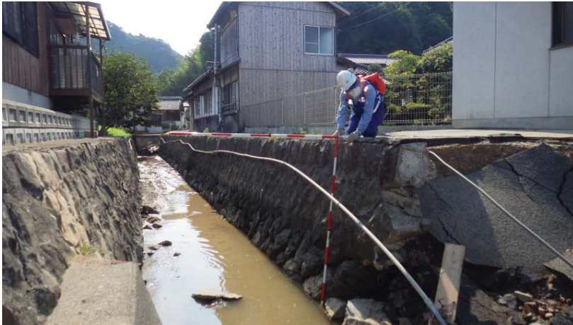
宇和島市内での現地調査（河川）
