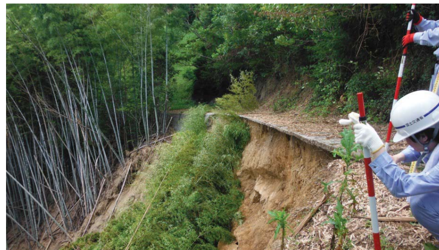
宇和島市内での現地調査（道路）
