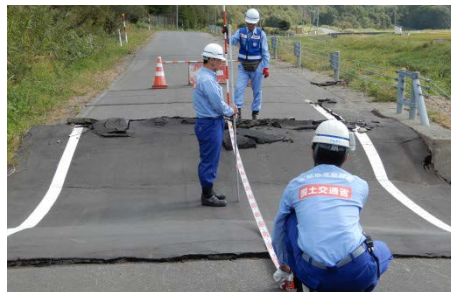
9/14厚真町内での現地調査(道路調査班)
