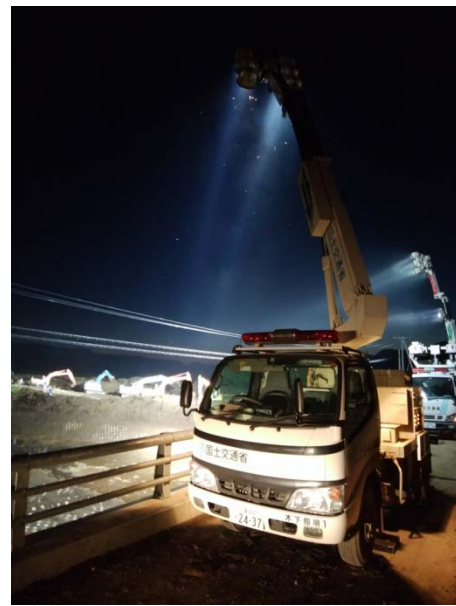
9/11厚真町の応急復旧への夜間照明(応急対策班)
