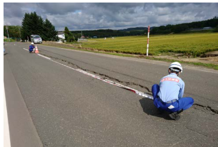
9/12厚真町内での現地調査(道路調査班)
