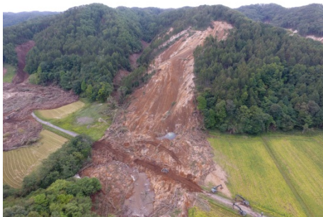
厚真町の土砂崩れ(ドローンによる撮影)
