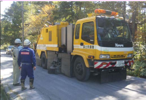
路面清掃車による降灰除去作業
