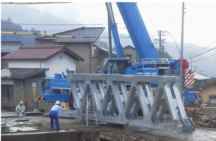
仮設橋設置作業
