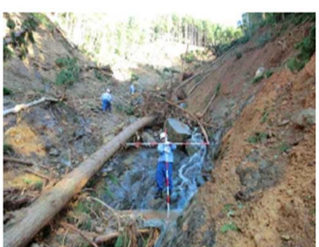
【土砂崩れ現場調査(砂防班)】
