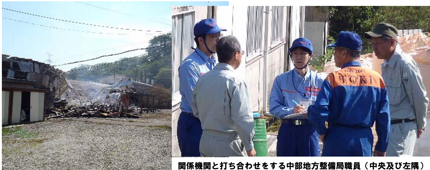
朝を迎え、火災のおそれが無くなった現場
