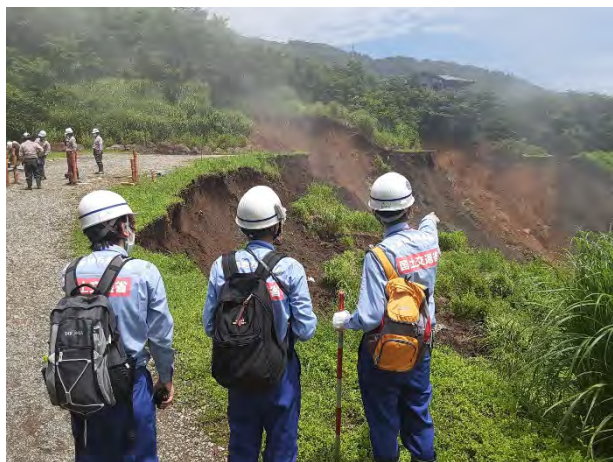
被災箇所の調査
