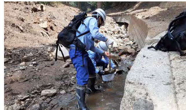
逢初川中流部の被災調査
