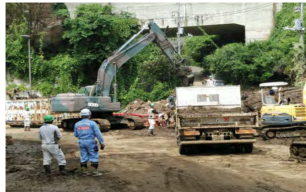
啓開作業の現地調査
