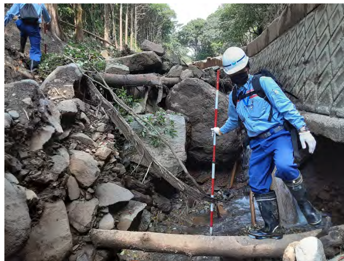
砂防堰堤の被災箇所の調査
