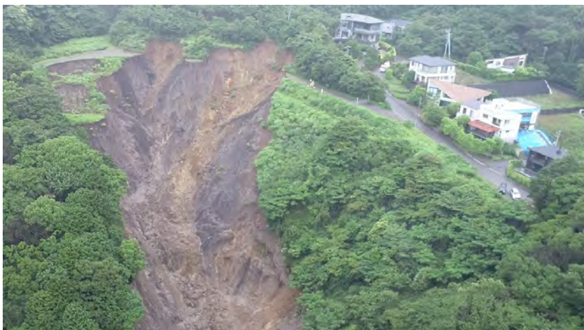
被災箇所のドローン調査(源頭部)
