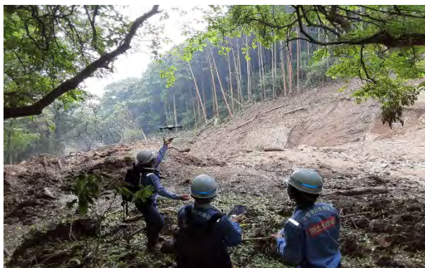
ドローンを活用した砂防堰堤上流部の点検
