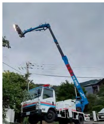
照明車の設置状況
