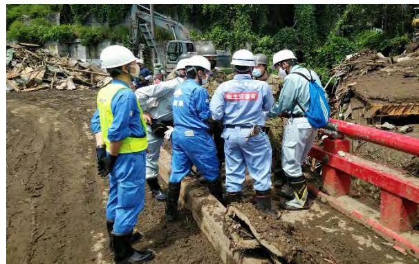
関係機関と流入土砂の対処方法を打合せ
