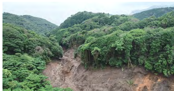
源頭部から下流を撮影
