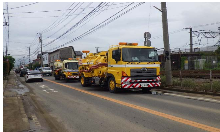
土砂で詰まった道路側溝の清掃を実施（応急対策班）
