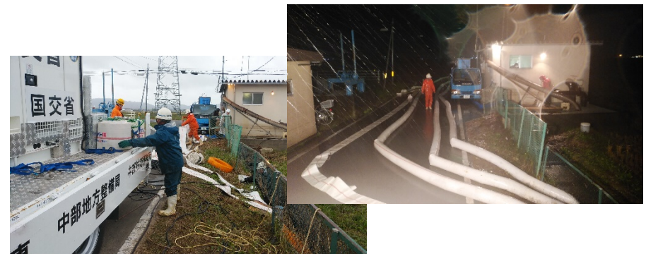
宮城県角田市 排水作業(応急対策班)
