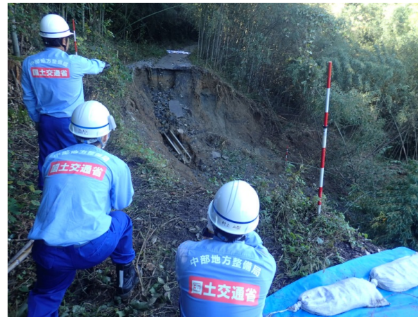
福島県いわき市遠野地区 被災状況調査(砂防調査班)
