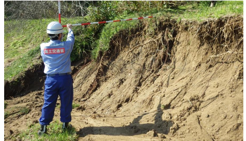
福島県いわき市常磐志座地区 被災状況調査（砂防調査班）
