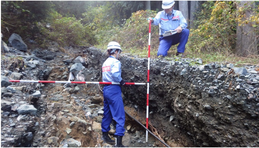
福島県相馬市山上前原 銅谷川被災状況調査（河川調査班）
