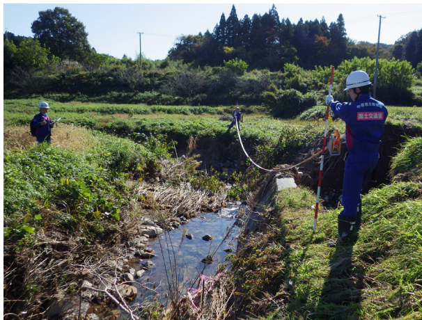
宮城県伊具郡丸森町 ウスキ川 被災状況調査(河川調査班)
