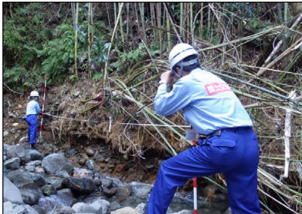
西沢川(福島県南相馬市)被災状況調査 (河川調査班)
