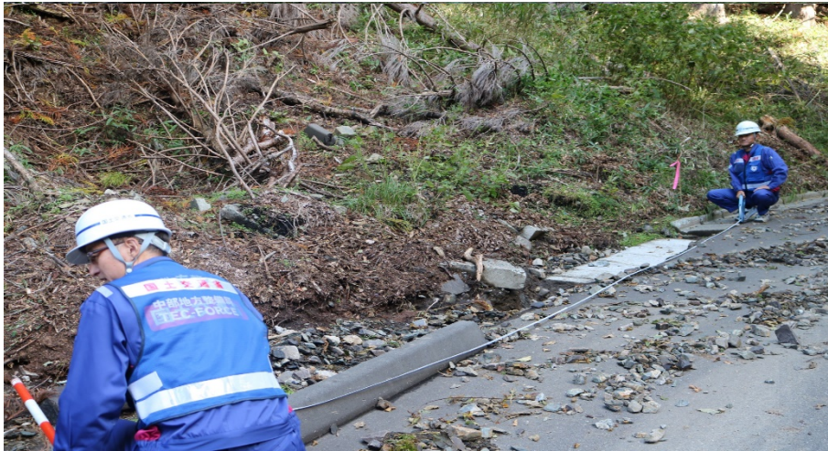
岩手県釜石市鍋倉峠付近 被災状況調査
