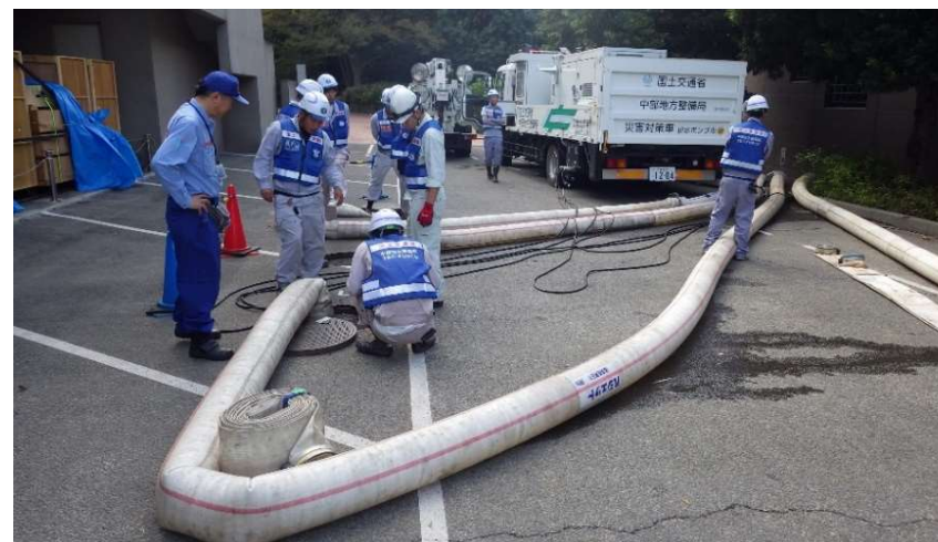
排水ポンプ車と排水作業状況
