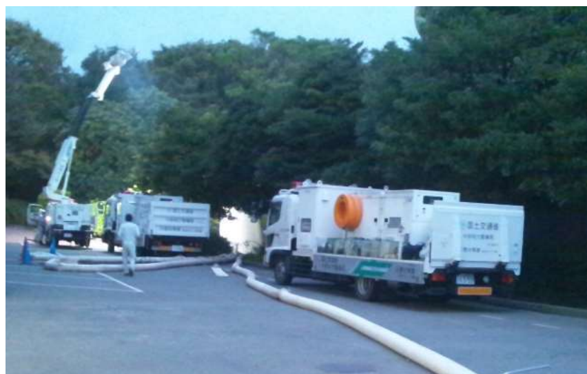
夜間排水作業に向け照明車を設置
