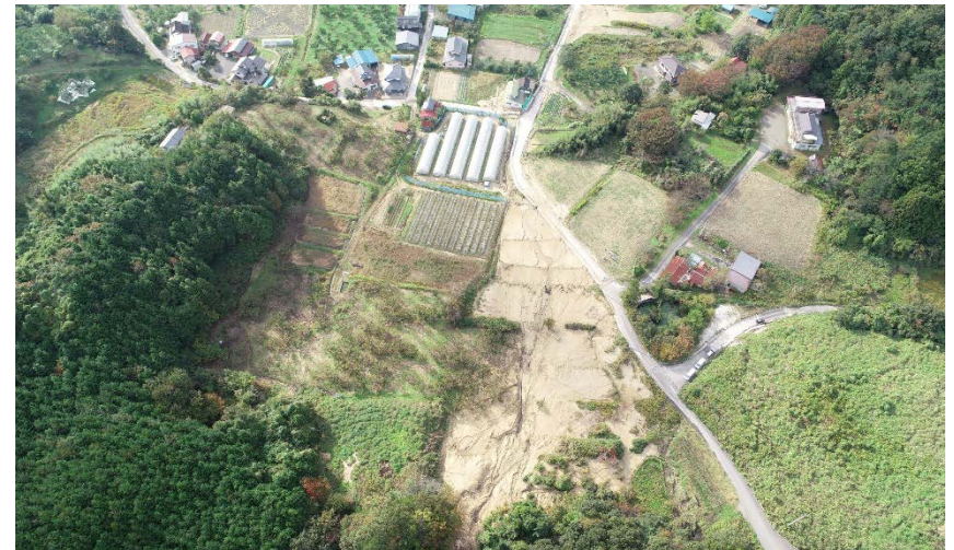
伊達市月舘町 被災状況調査(ドローン撮影)(砂防調査班)
