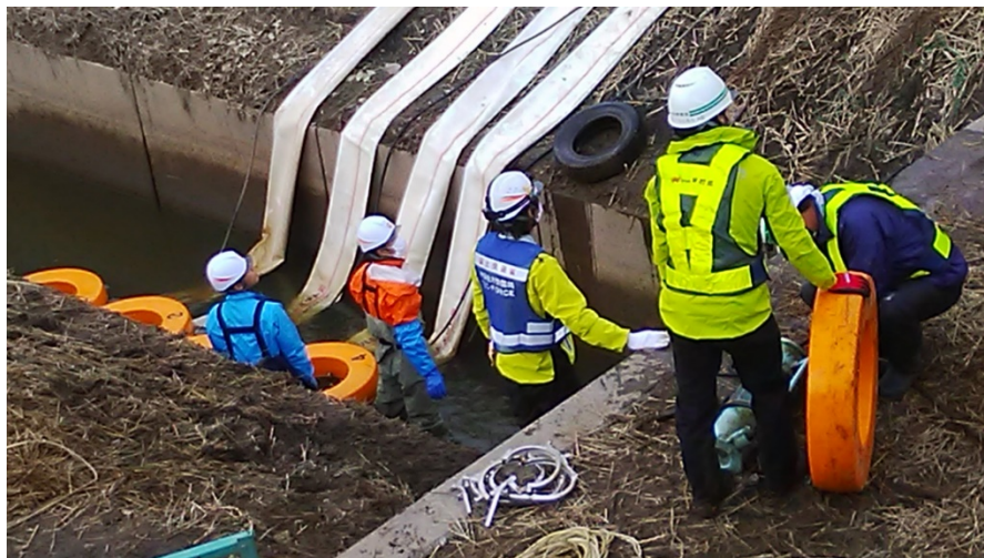
鶴田川砂崎橋 排水作業状況(応急対策班)
