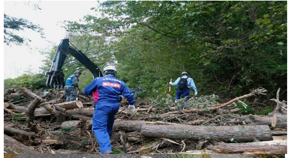
岩手県下閉伊郡山田町船越地内 被災状況調査
