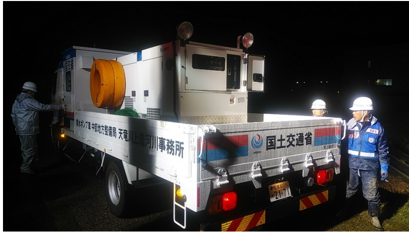
宮城県角田市 排水作業着手(応急対策班)
