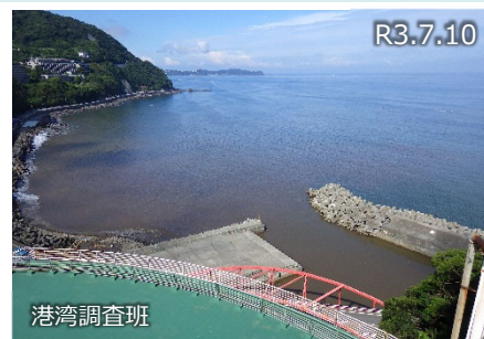
ドローンによる港の状況調査
