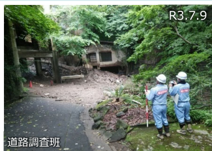
被害状況の調査
