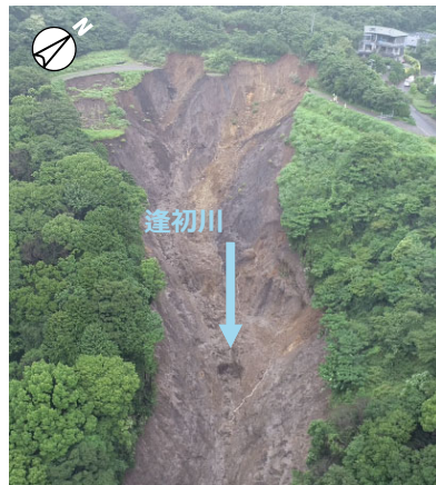
源頭部の崩壊状況
