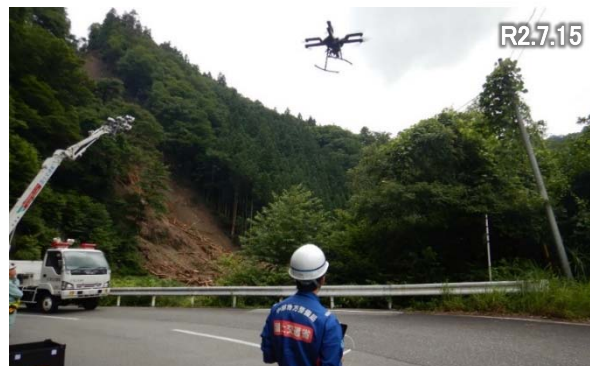
全天候型ドローンによる被災状況調査
