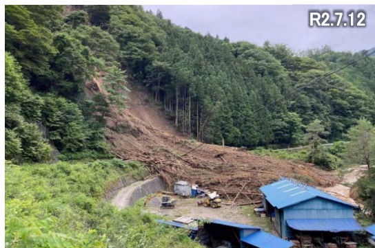
法面崩落による被災状況
