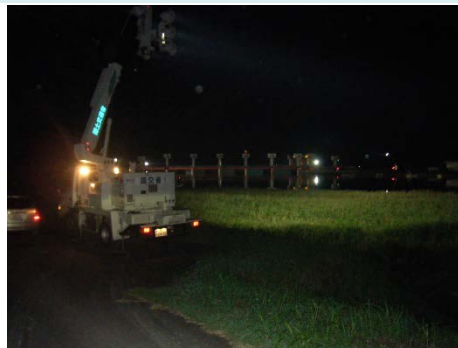
油流出防止のため照明車で監視活動を支援
