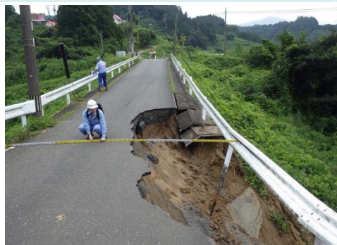
多久市内での現地調査（道路）
