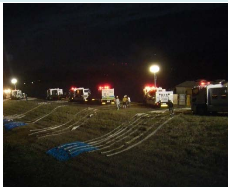
六角川での排水作業
