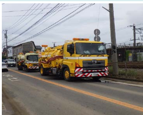
道路側溝の清掃作業
