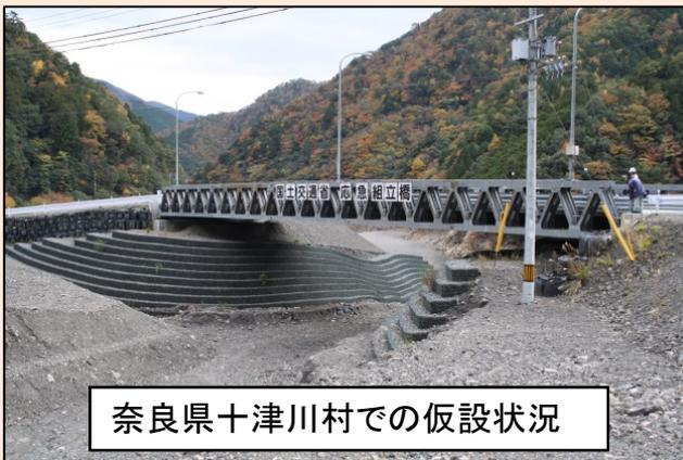
橋や道が流され、緊急に交通路を確保する必要がある場合に、組立式の橋を短期間で架設できます。20t～25tの車両が通行できます。保管事務所毎の規格は以下のとおり。
