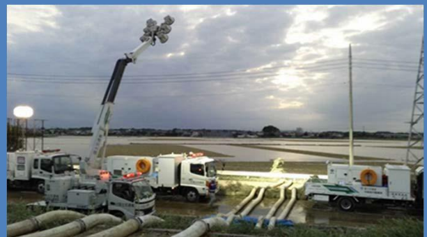
浸水を早期に解消するため24時間体制で排水作業を実施
