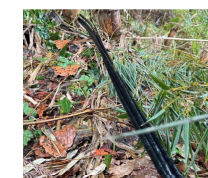
ケーブル網の応急復旧 (地面敷設)
