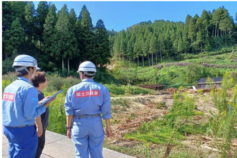
【河川班 被災状況調査(輪島市西脇町)】
