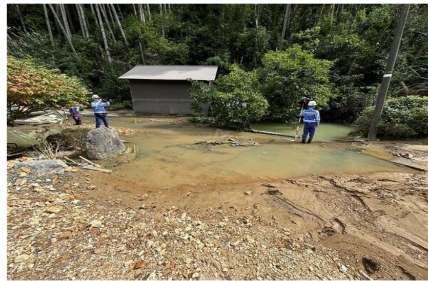
【道路班 被災状況調査（輪島市町野町）】
