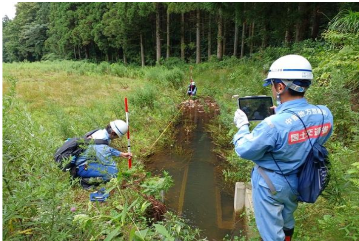
【砂防班 被災状況調査（山形県庄内町）】
