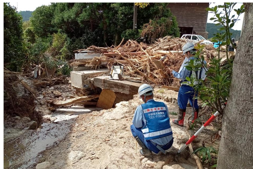
【道路班 被災状況調査(輪島市町野町)】
