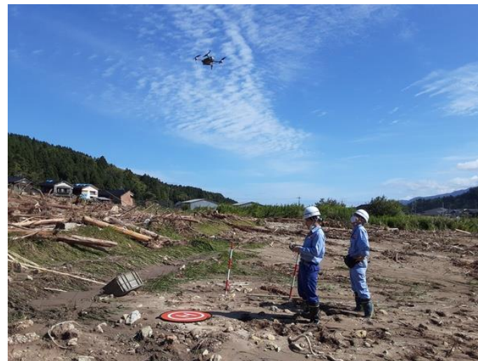
【砂防班 ドローンによる調査(石川県輪島市)】
