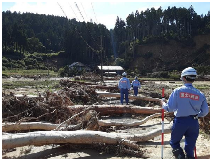
【道路班 被災状況調査(石川県輪島市)】
