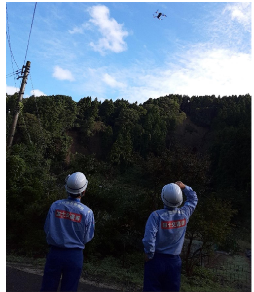
【砂防班 被災状況調査(輪島市門前町)】
