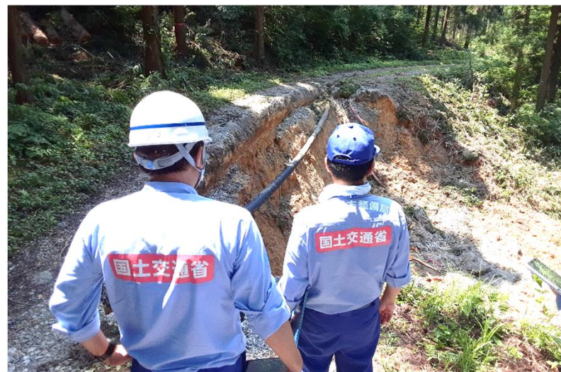
【被災状況調査（山形県庄内町）】
