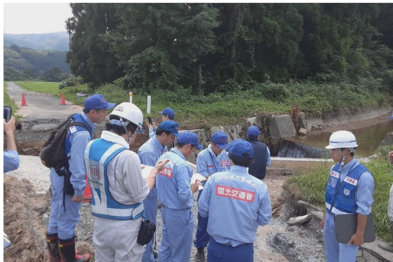
【被災状況調査（山形県庄内町）】
