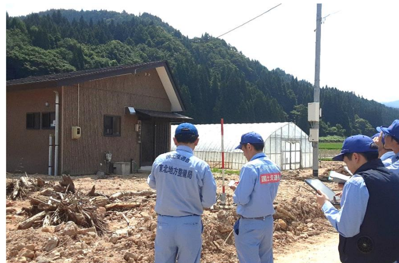
【被災状況調査（山形県庄内町）】
