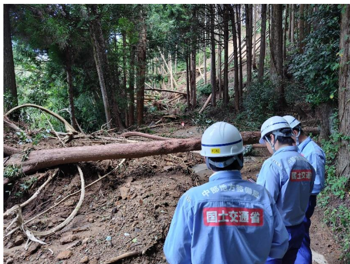
【道路班 被災状況調査(輪島市門前町)】
