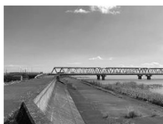
木曽下流巡視(完了) 異常ありません
