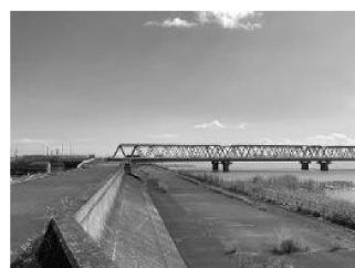
木曽下流巡視(完了) 異常ありません
