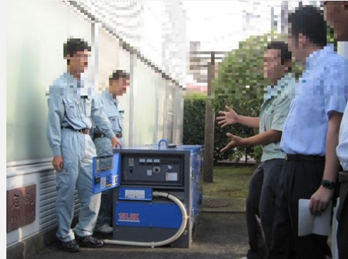
▲屋外発電機の取扱い訓練
