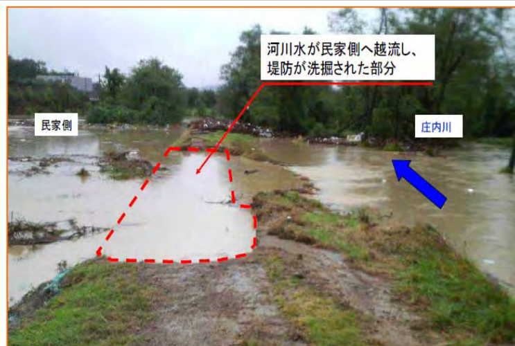
①越水による堤防洗掘 (20日16時頃の状況)
