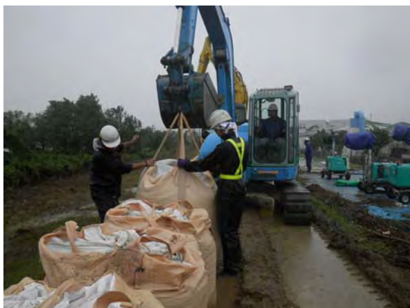
②大型土のうによる対策実施状況1 (21日12時頃の状況)
