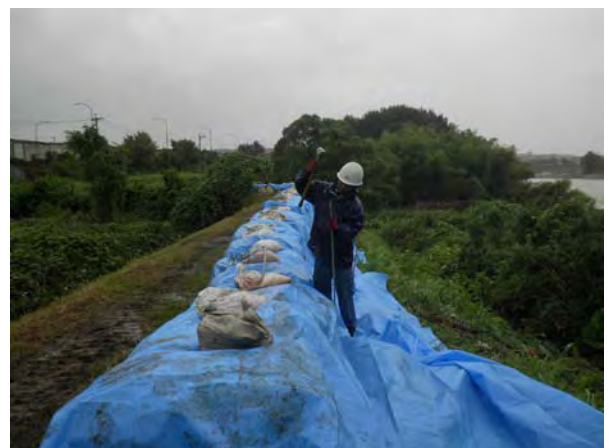
③大型土のうによる対策実施状況2 (21日12時頃の状況)
