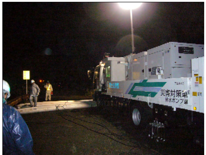
9月3日 三重県南牟婁郡御浜町の志原川における排水作業
