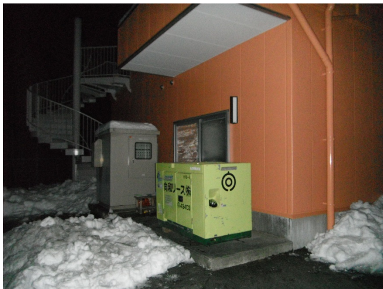
臨時電源復旧のため発動発電機を設置
