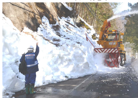
【上野村 村道1041号の作業状況】
