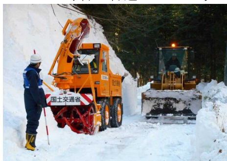
【神流町 町道60号の作業状況】
