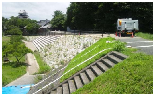
【山国川支川中津川に配備された排水ポンプ車】
