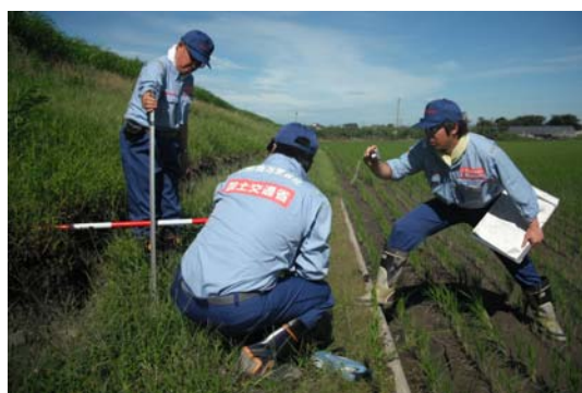
【堤防状況調査（矢部川右岸 11.9km 付近）】
