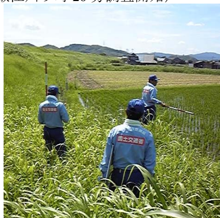
【堤防状況調査（矢部川支川飯江川左岸）】
