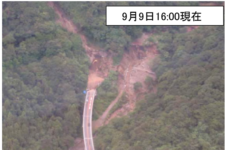
城山トンネル東坑口土砂崩落状況(9月9日撮影)
