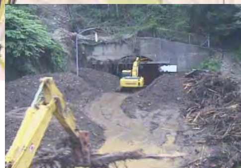
復旧状況(9月10日)
