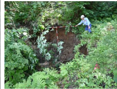
岩手県旧衣川村での点検状況
