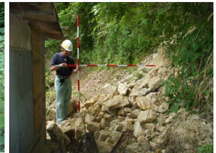
宮城県旧迫町での点検状況
