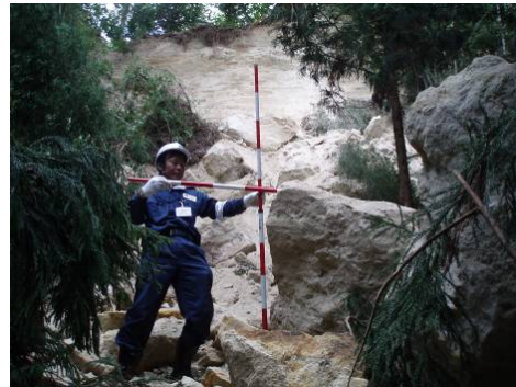
宮城県旧一迫町での点検状況
