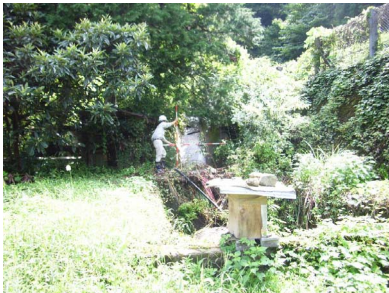
土砂流出した溪流の調査状況 （9月4日撮影）
