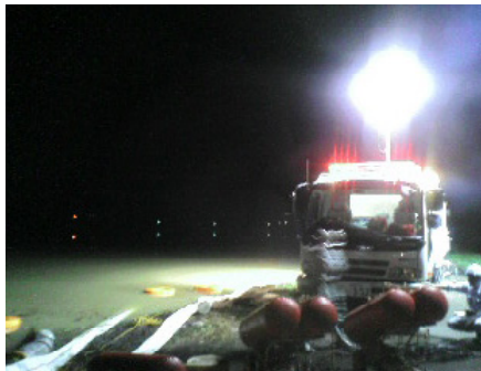
←ポンプ車による排水作業状況
